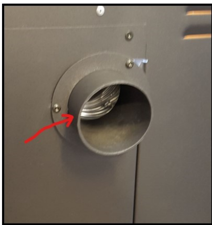
Fig. 29: Montare il raccordo doppio.
