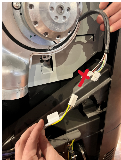
Fig. 63: Collegamento del cavo
