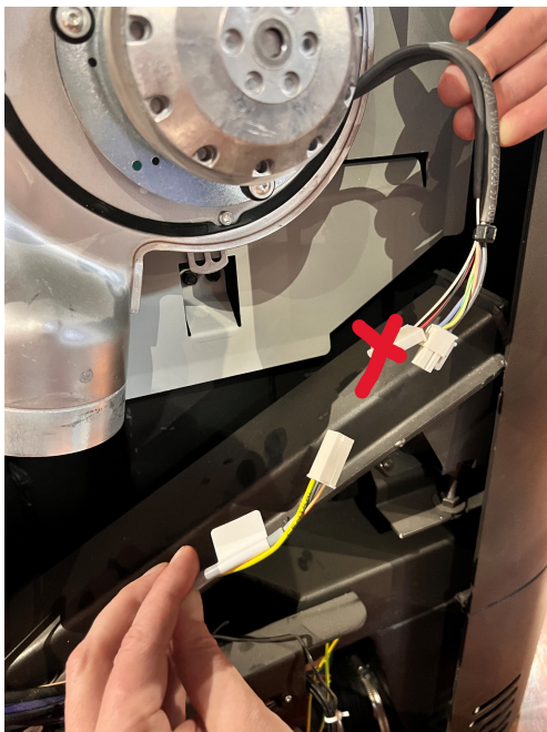
Fig. 63: Raccorder les câbles
